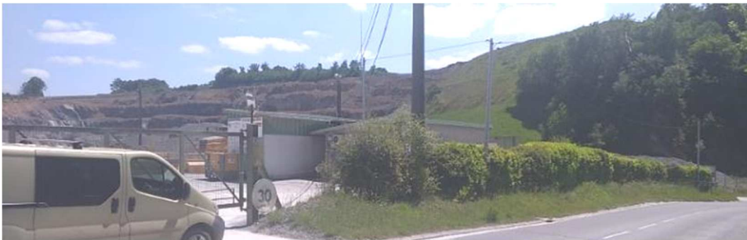
En venant de Lanouaille, la carrière apparaît brièvement au détour d'un virage
