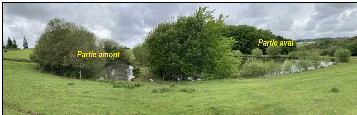
Illustration 6 : Vue de la retenue depuis le sa partie Ouest
