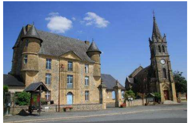
Le cœur du village de Dussac est dominé par l'église Saint-Pierre-ès-Liens et le château inscrit à l'inventaire des monuments historiques, XVIII e siècle, flanqué d'une tourelle aux quatre angles et faisant office de groupe scolaire.
