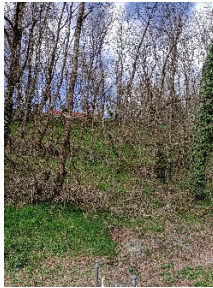
Le boisement de Robinier sur le talus de la RD 707.
