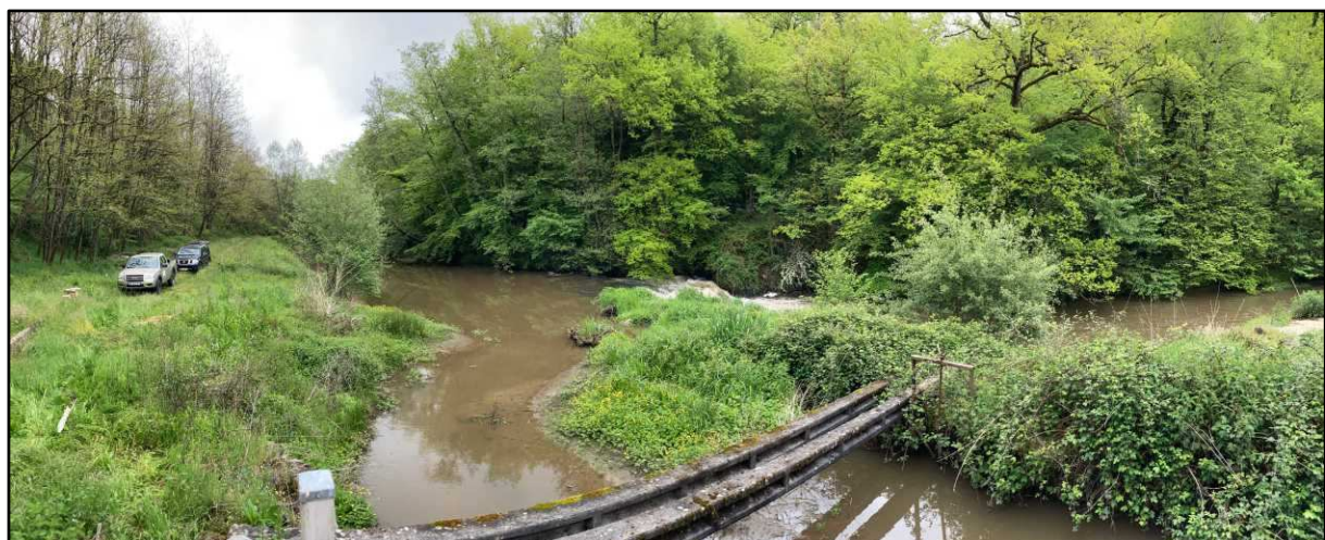
Illustration 3 : la Loue au niveau du futur pont à créer
